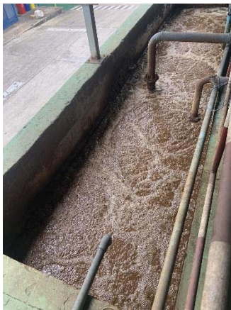
ภาพที่ 9 ระบบบำบัดน้ำเสียทางชีวภาพแบบตะกอนเร่ง
